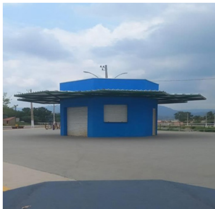
FOTO 01: Imagem do quiosque localizado na Rua Beira Rio, esquina com rua Rio de Janeiro – Bairro Rio Verde. Fonte: PROSAP.
