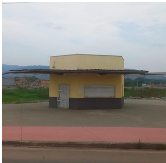
FOTO 03: Imagem do quiosque na Rua A2, esquina com a Av. Castanheira, Bairro Tropical
